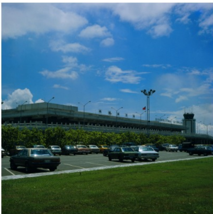
圖7 高雄航空站 案名：幼稚園、航空、道路橋樑、空照圖 檔號：0066/2017/1 來源機關：行政院新聞局 管有機關：國家發展委員會檔案管理局
